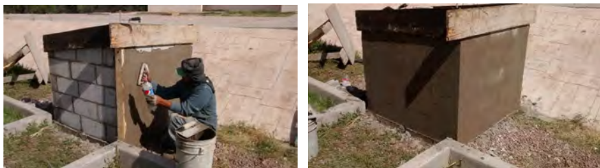
Figura 6. Proceso de repello de los muros
