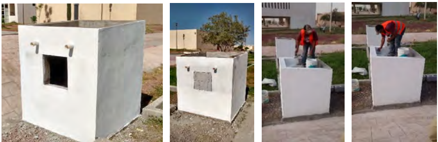
Figura 8. Pintura e impermeabilización
