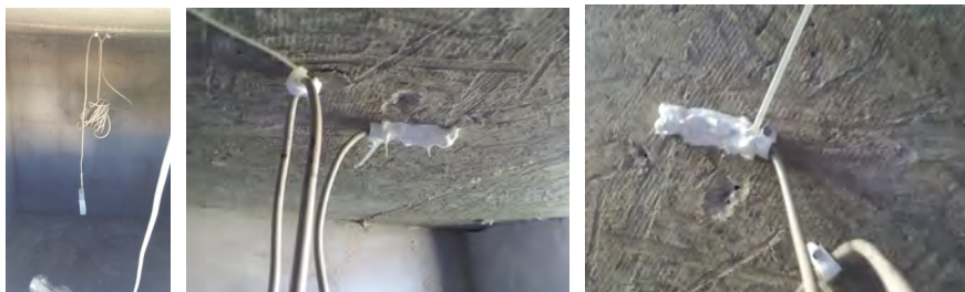
Figura 11. Sensores instalados para las mediciones internas
