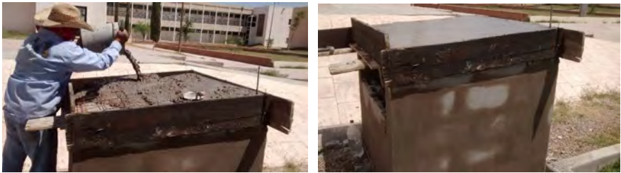
Figura 7. Colado de los de concreto de 10 cm
