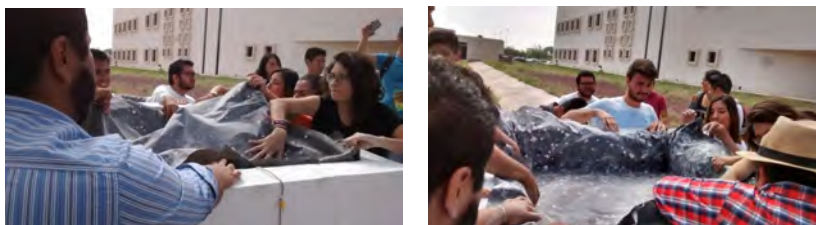
Figura_12.- Instalación de las cuatro capas de plástico en uno de los módulos experimentales.
