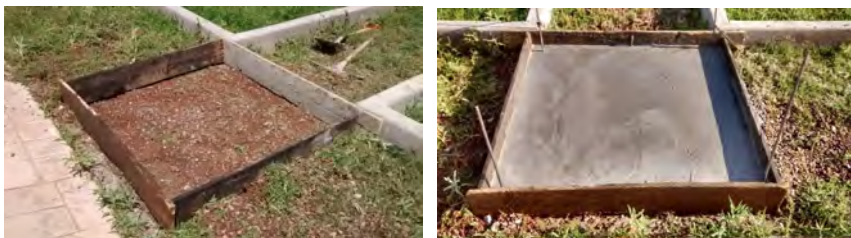
Figura 4. Llosa de cimentación de los módulos experimentales
